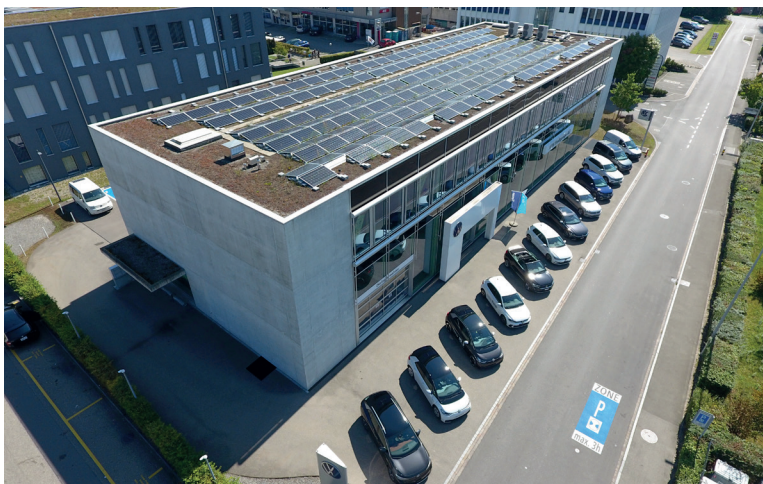
Auf dem Dach des Showrooms wurde Ende 2020 eine Photovoltaik-Anlage erstellt
